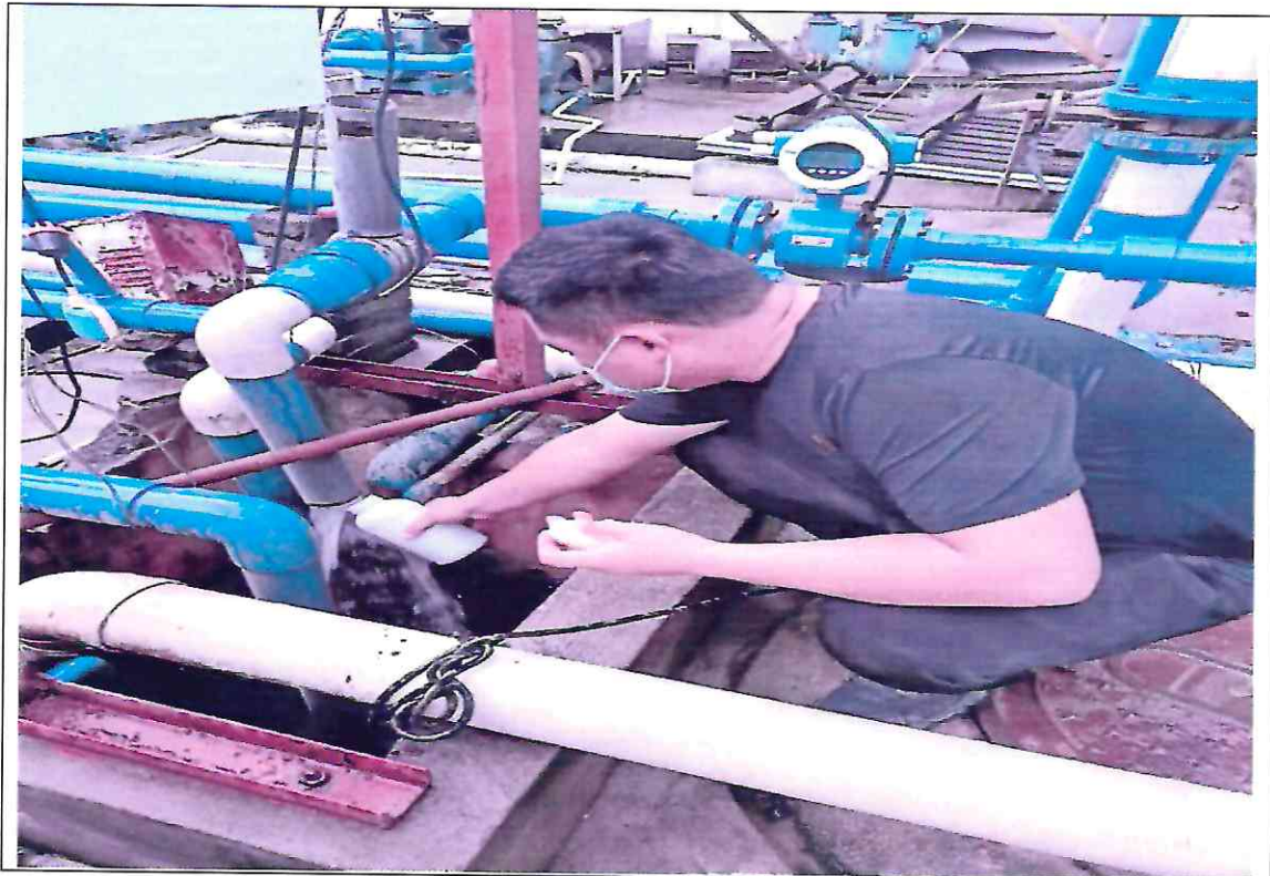
(一) 现场监测照片
