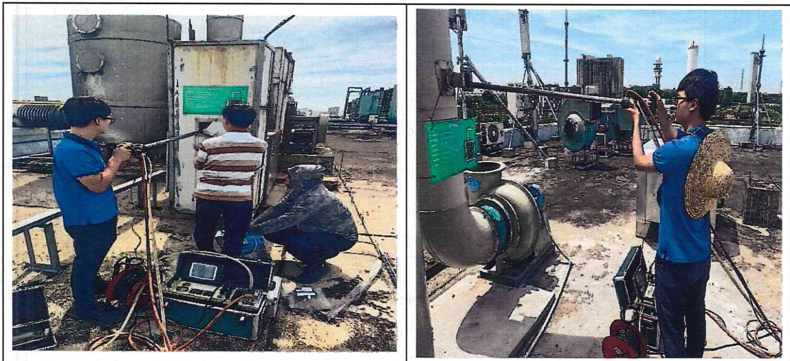
(一) 现场监测照片
