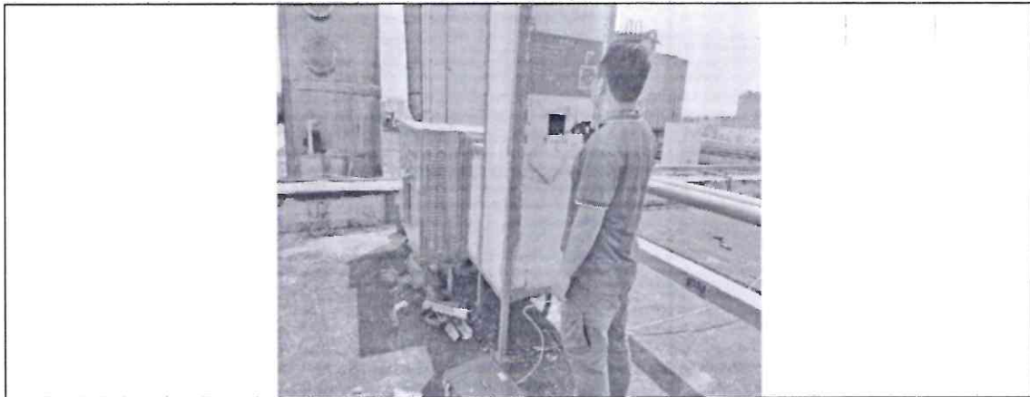
(二) 现场监测照片
