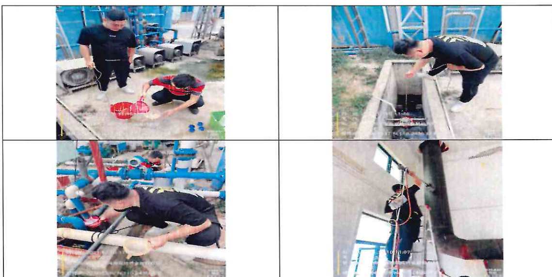
(二) 现场监测照片
