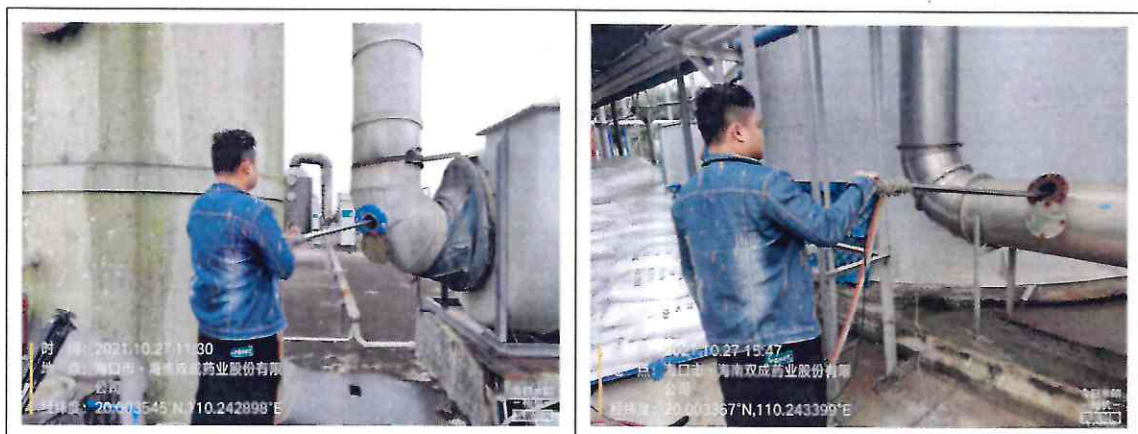
(二) 现场监测照片
