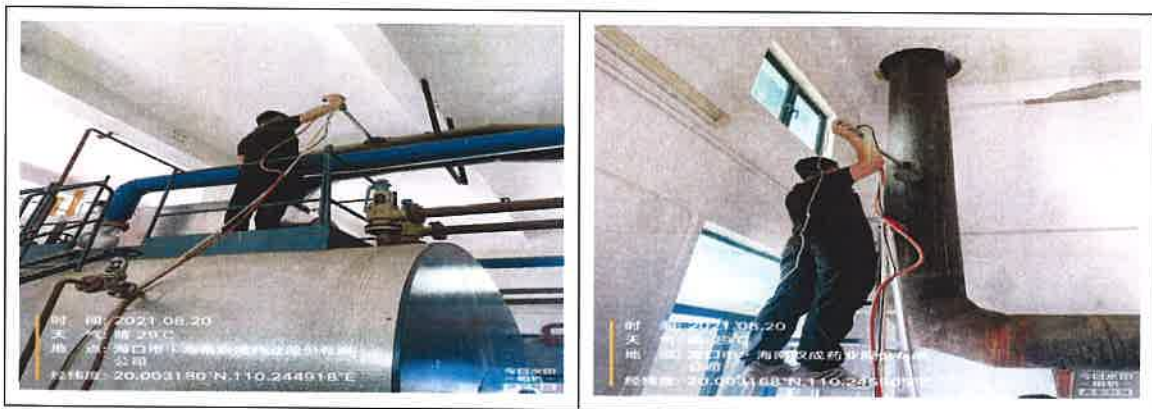
(二) 现场监测照片
