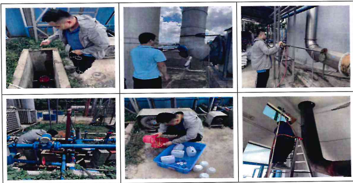
(二) 现场监测照片
